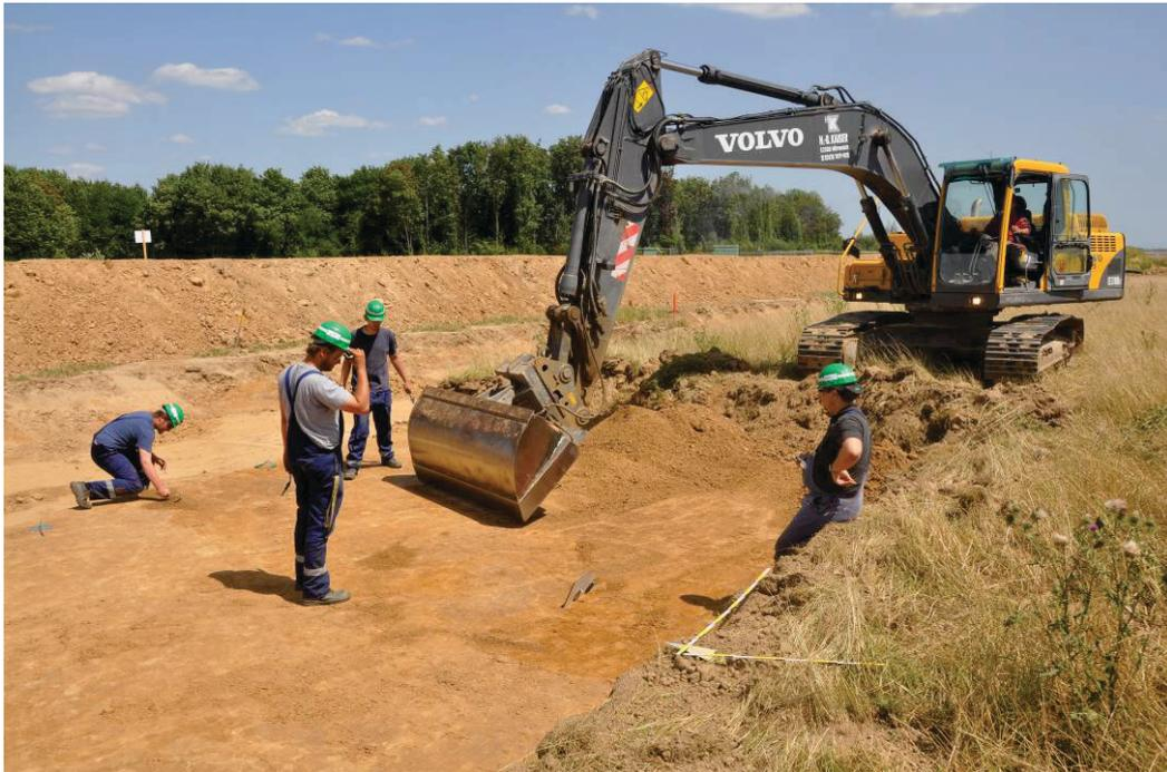
Abbildung 1 FR 2010/0037. Situationsphoto. Bagger beim Abziehen des Humus.
